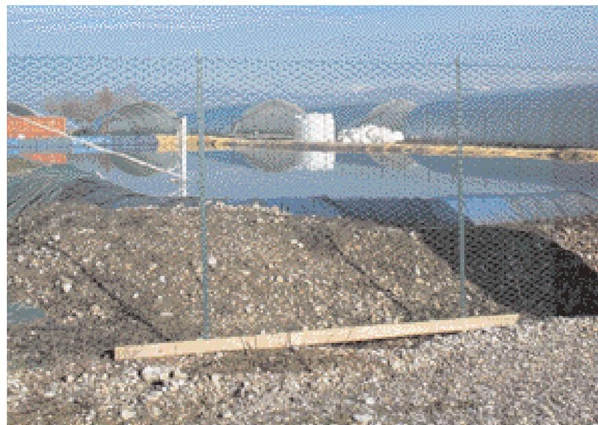
Questo dovrà essere completamente recintato mediante idoneo parapetto alto almeno 1 m. (è consigliabile la sua segregazione con rete metallica non arrampicabile alta almeno 1,80 m.).
