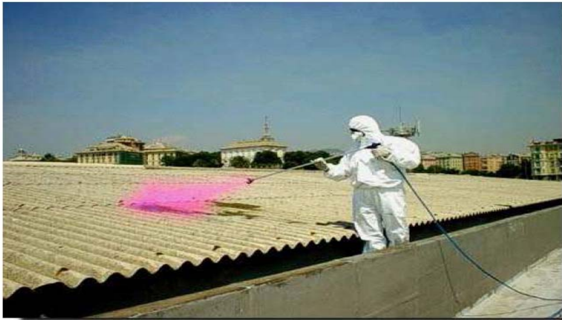
Bagnatura del cemento-amianto
