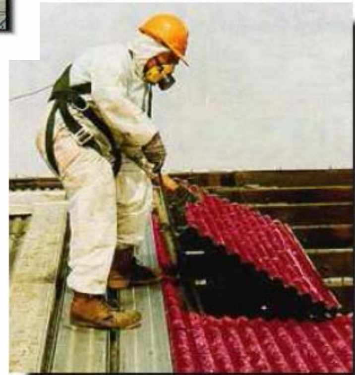
Rimozione lastre in eternit
