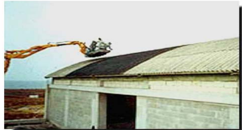
Posa della sovracopertura
