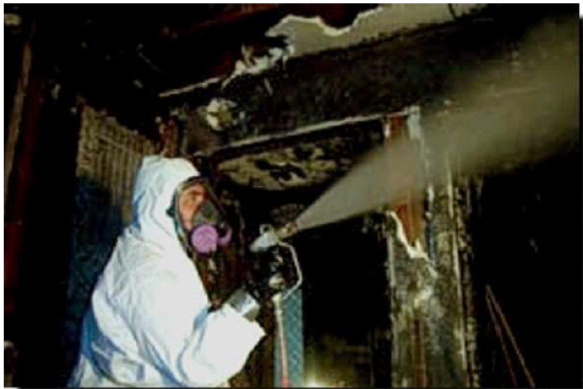
Impregnante per evitare la dispersione di fibre d'amiant
