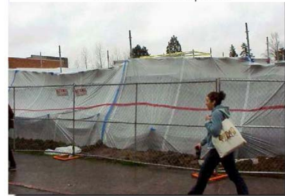
Cantiere di lavoro
