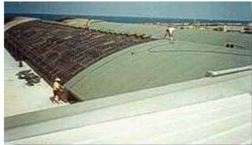
Rivestimento di una copertura
