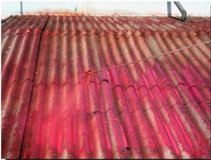
Impregnante per evitare la dispersione di fibre d'amianto
