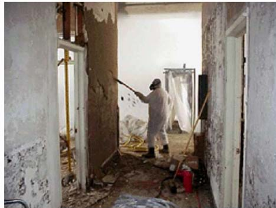
Rimozione rivestimento dopo il trattamento
